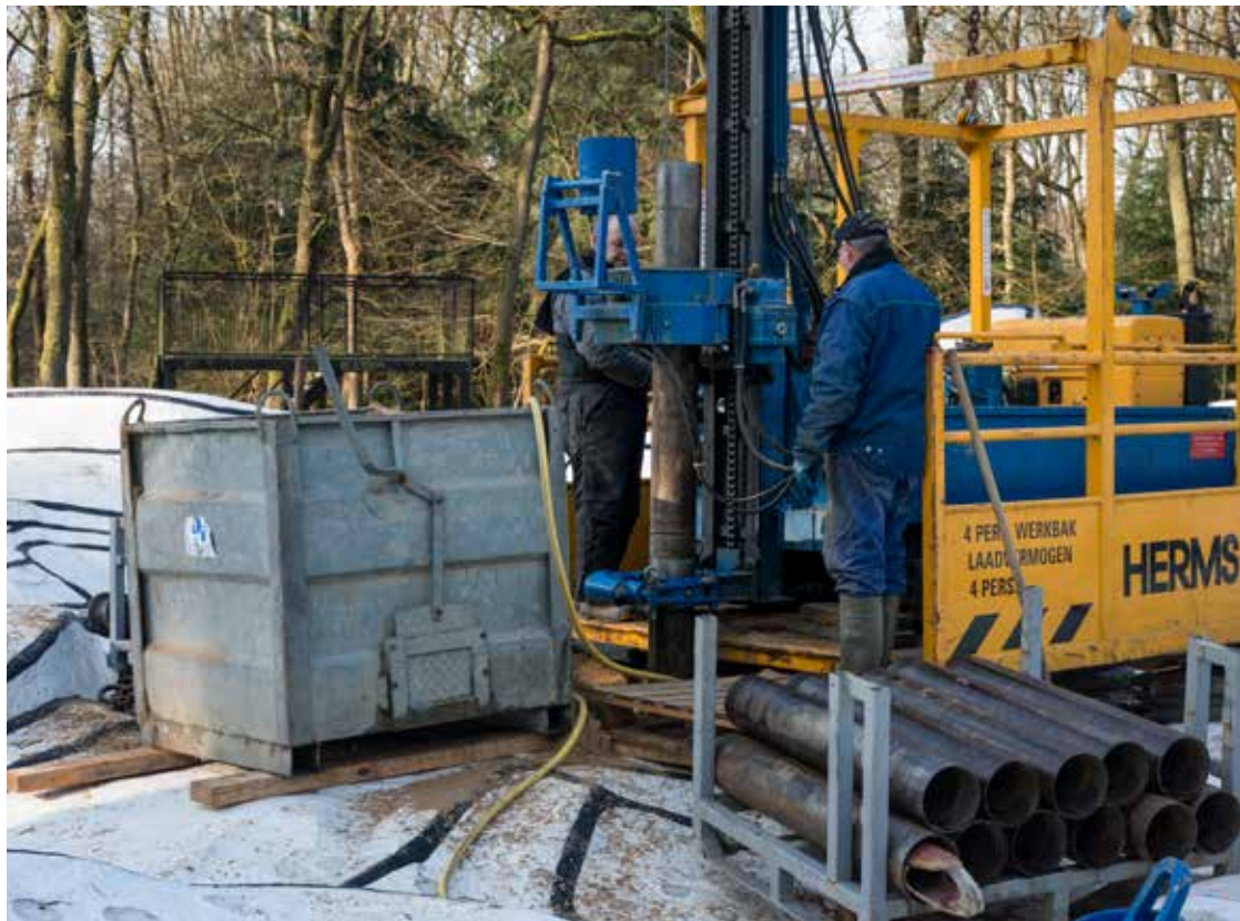
Het aanleggen van het nieuwe afwateringssysteem
