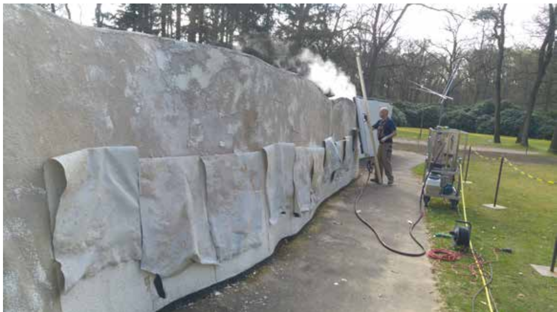
Het verwijderen van de PVC verf van de buitenmuren
