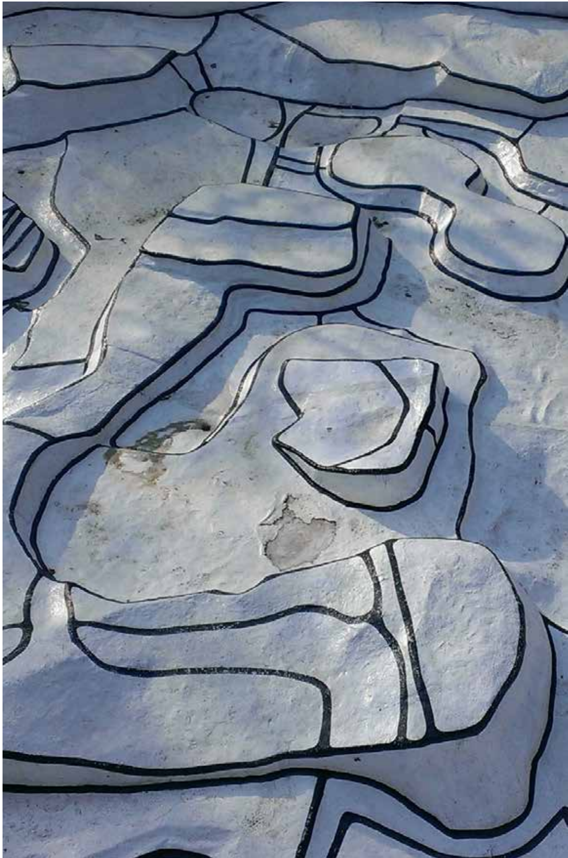
Schade aan het betonnen plateau en latere overschildering van de zwarte belijning
