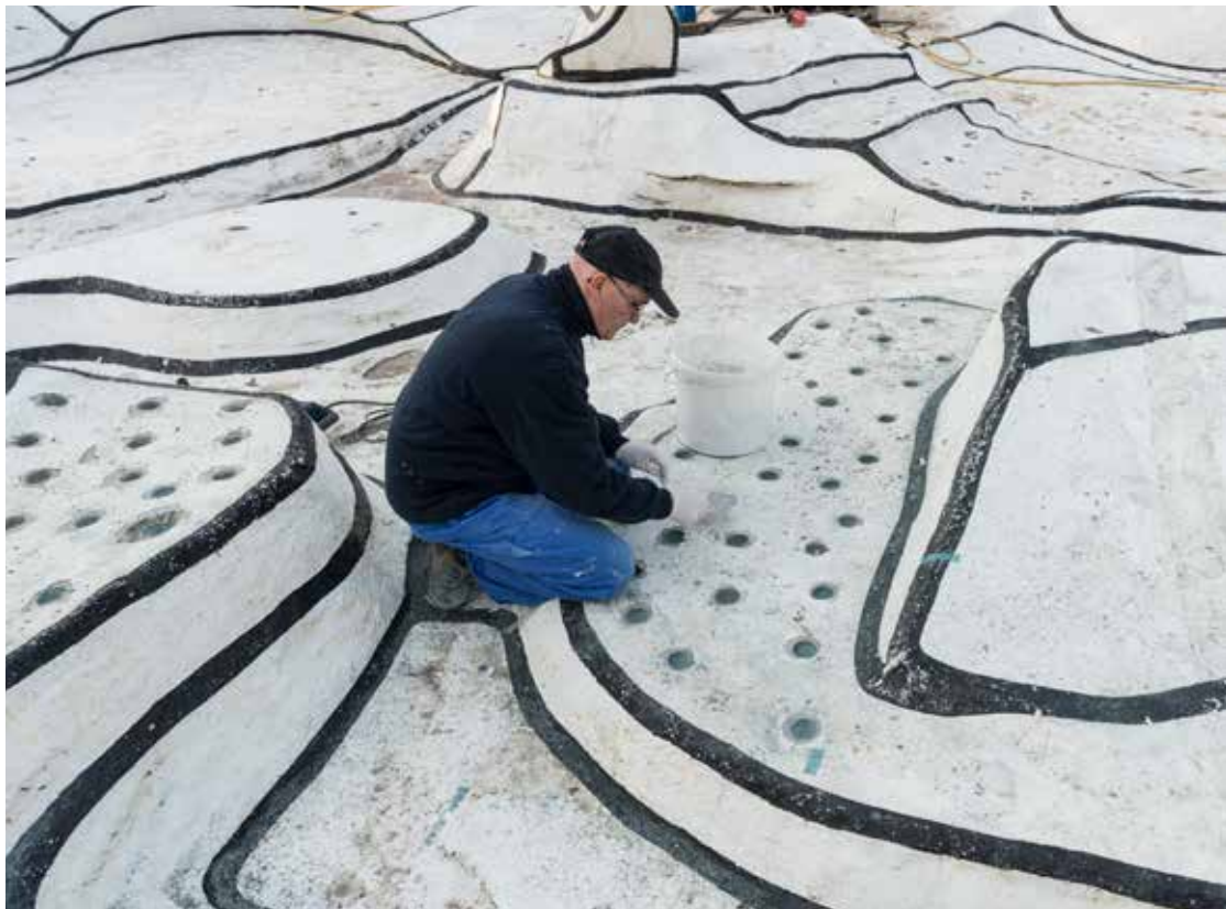
Stabilisering van het betonnen plateau
