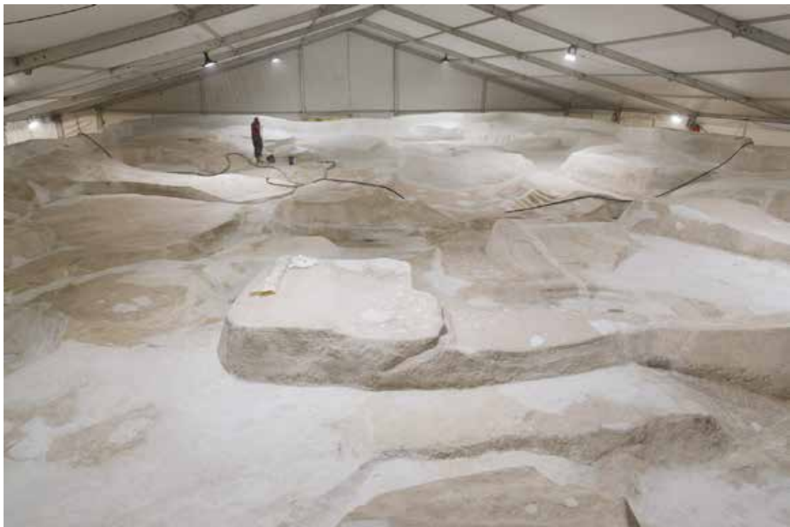
Hersteld betonplateau voor het aanbrengen van spuitmortellaag
