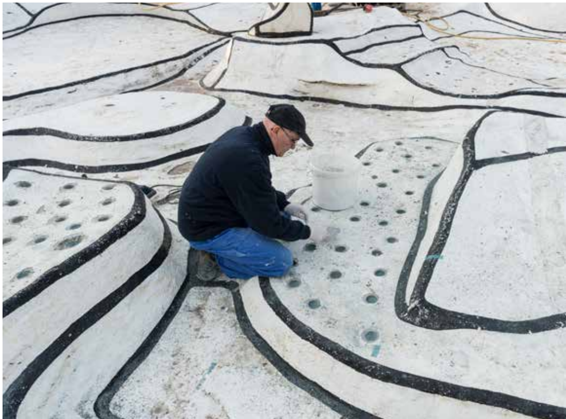
Stabilisering van het betonnen plateau
