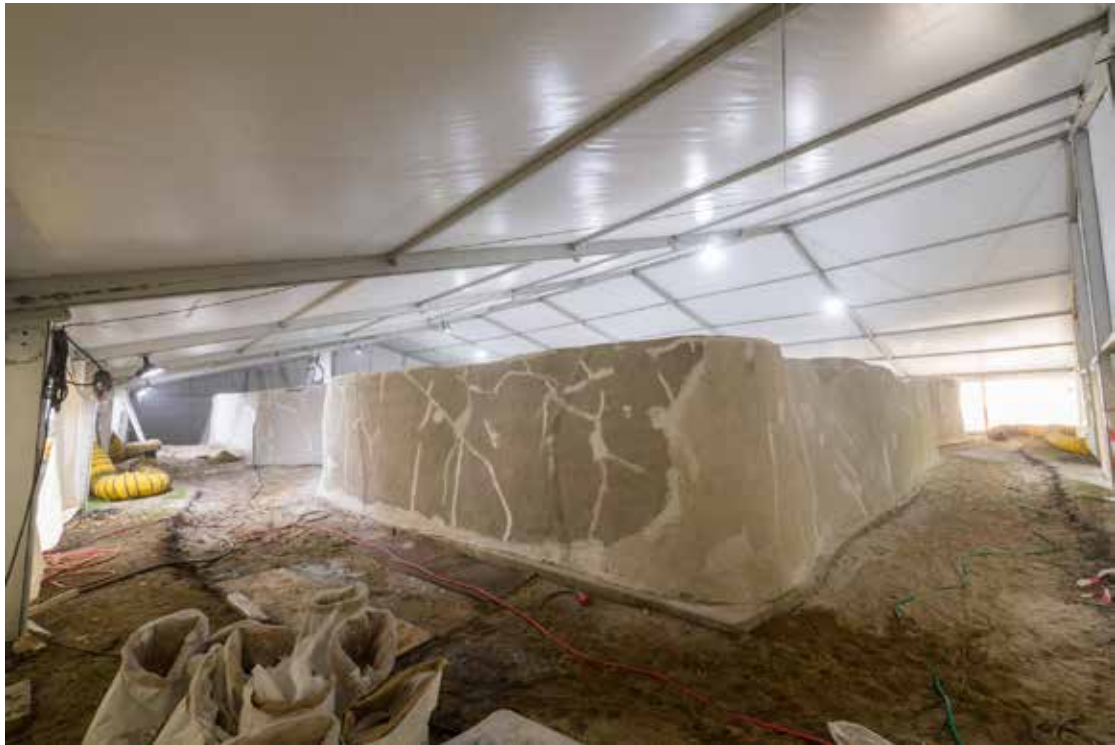
Gerepareerde betonnen buitenmuren voor het aanbrengen van de spuitmortellaag
