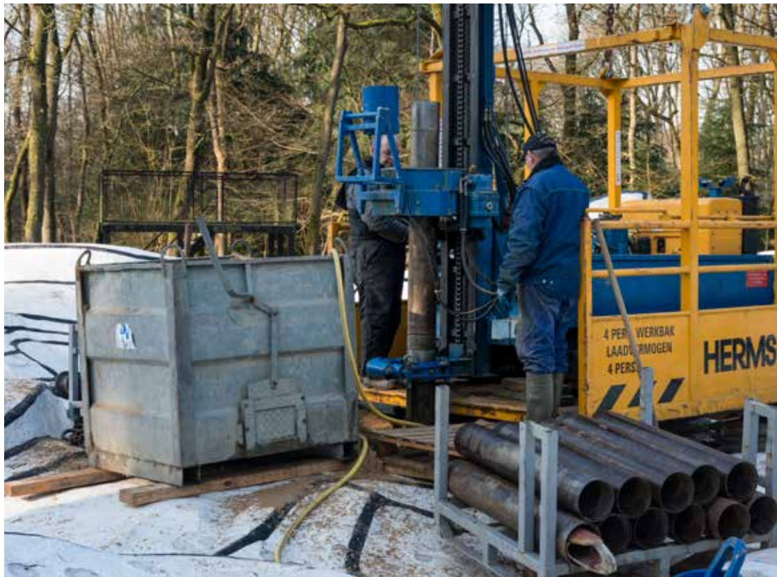
Het aanleggen van het nieuwe afwateringssysteem
